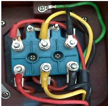
6 đầu dây ra trong hộp nối dây
